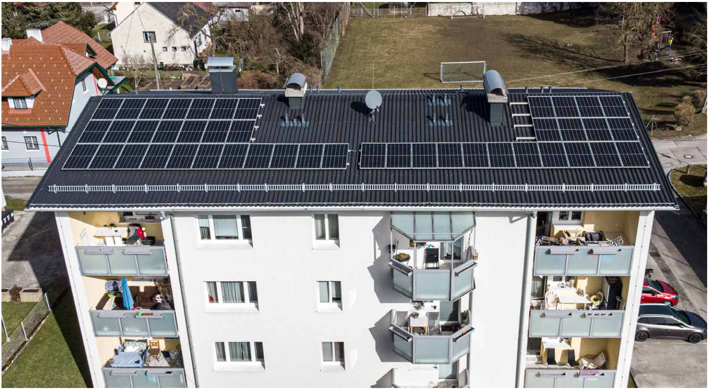
CCE Photovoltaikanlage Zistlerstraße
