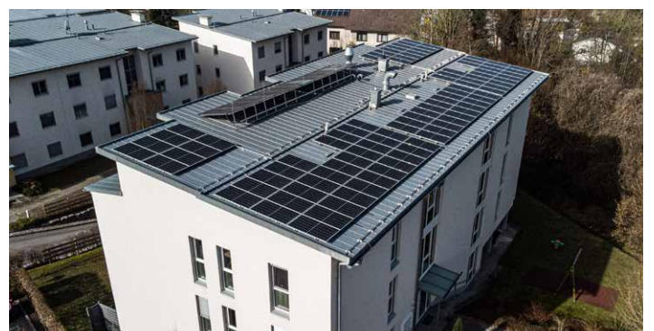
CCE Photovoltaikanlage Grabenhoferweg
