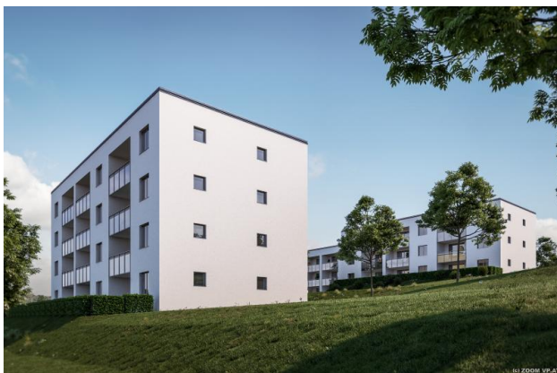
471 Foto Fassade 2.jpg
